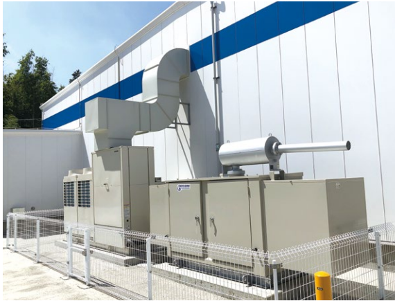
防爆エアコン施工例
